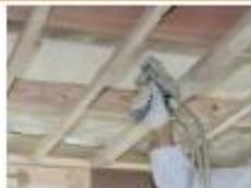
強力な自己接着力で、複雑な形状にも断熱材を隙間なく充填。隙間からの熱損失が大幅に減少します。
